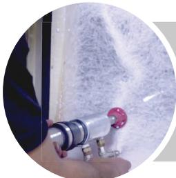
L'injection de billes de polystyrène, agglomérées avec un liant, dans les parois des murs forme un isolant à valeur thermique élevée.
